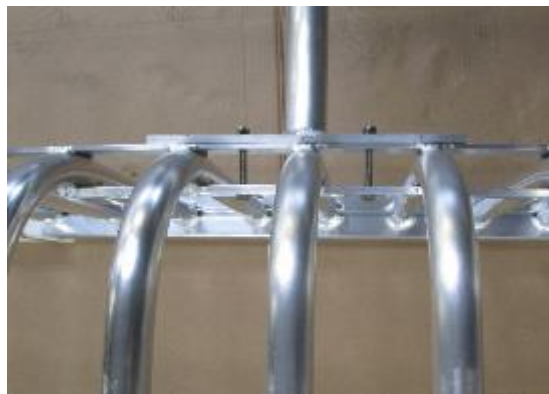
Fußplatte Strebe: Bohrungen deckungsgleich mit den Bohrungen in den Flachprofilen am Tor ausrichten
